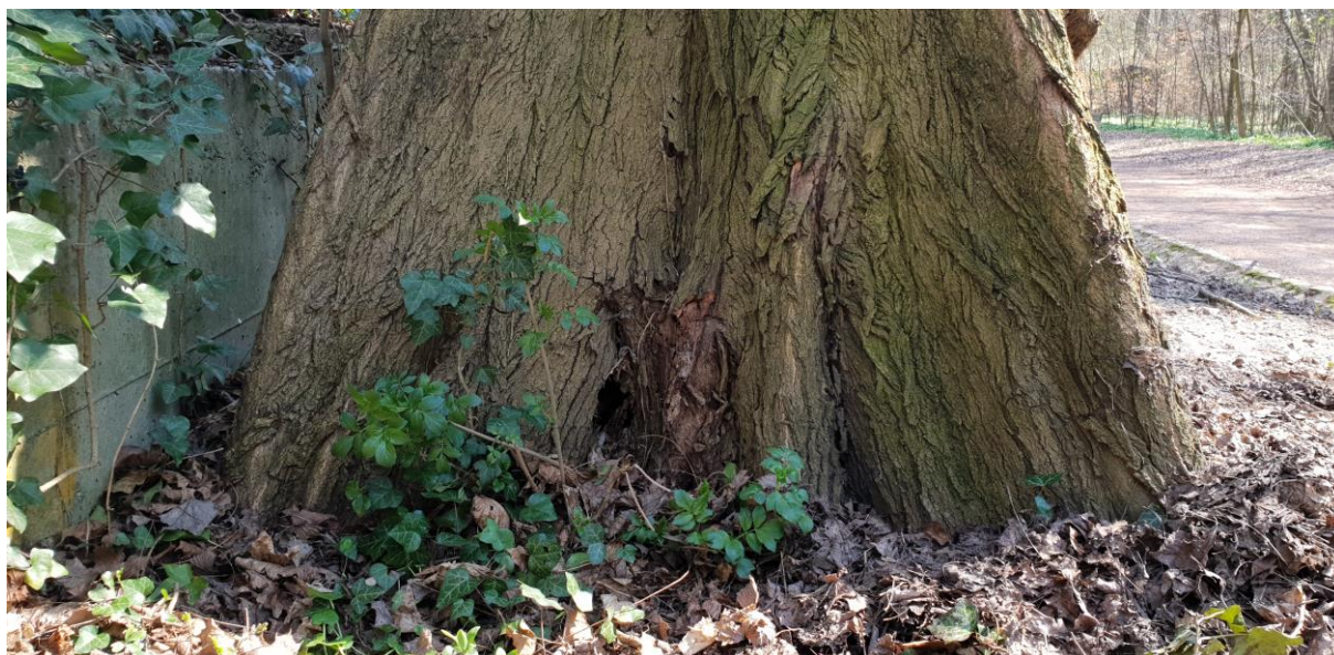
strom č. 9 – detail dutiny na báze kmeňa
