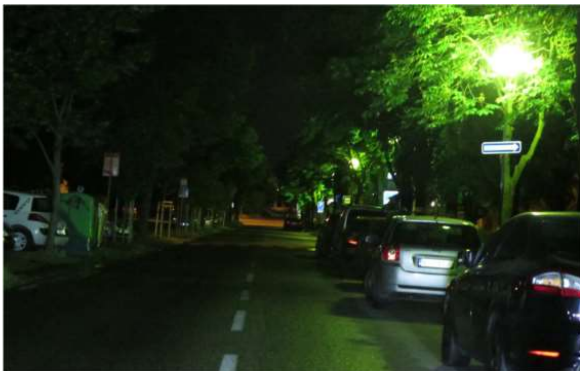
Obrázok č. 120 - Osvetlenie Černockého ulice so svietidlami s guľovým opálovým difúzorom Osvetlenie komunikácií s distribučnými stožiarmi
