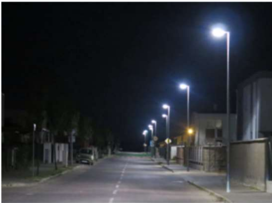
Obrázok č. 111 - Biela farba svetla zo svietidiel s halogenidovou výbojkou na Konopiskej ulici
