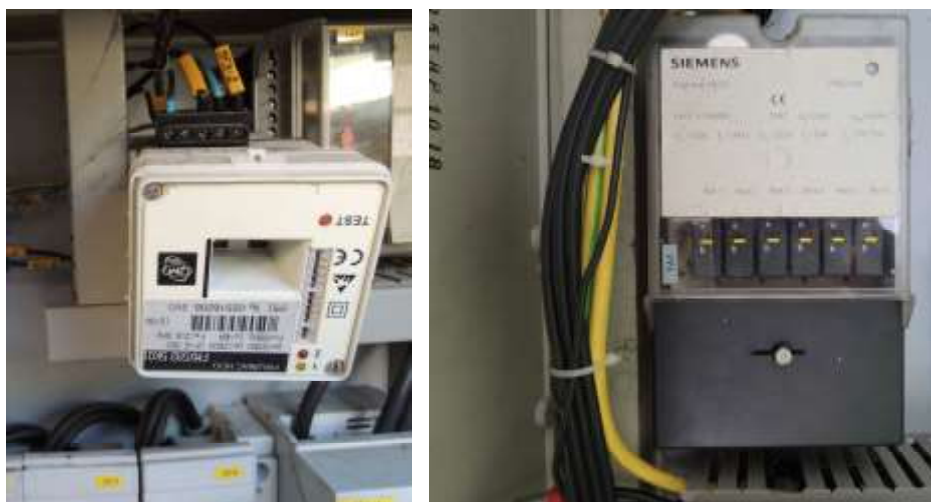
Obrázok č. 128 - Prijímače signálu HDO
