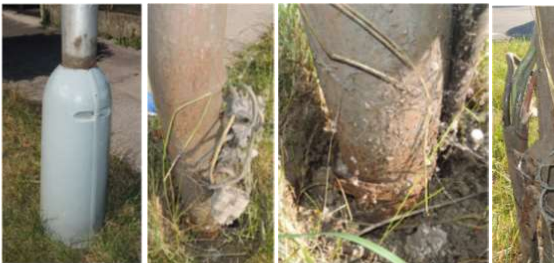
Obrázok č. 61 - Elektrovýzbroj a korózia spodku stožiaru č. 007/005 na Hodonínskej ul.
