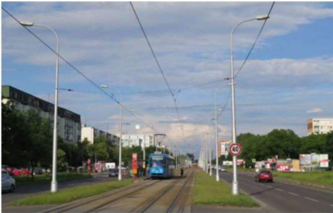
Obrázok č. 78 - Jednotanná osvetľovacia sústava s vnútornými radmi svetidiel na Ružinovskej ul.
