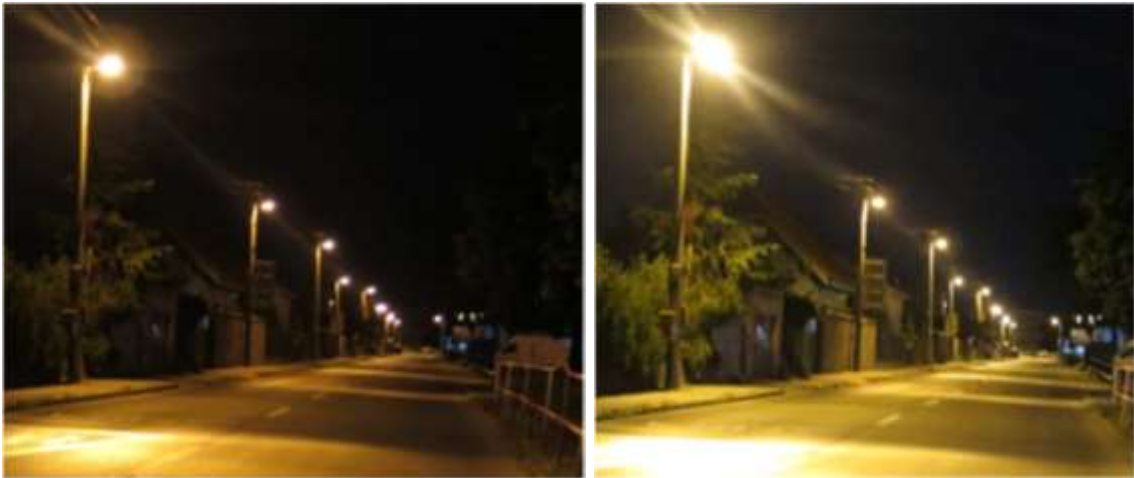
Obrázok č. 122 - Vysoko nerovnomerné osvetlenie svietidlami Trilux 9331 na Bulharskej ulici
