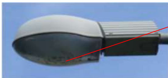
Obrázok č. 56 - Mierne znečistené svietidlo Trilux 9901 na Petržalskej ul.
