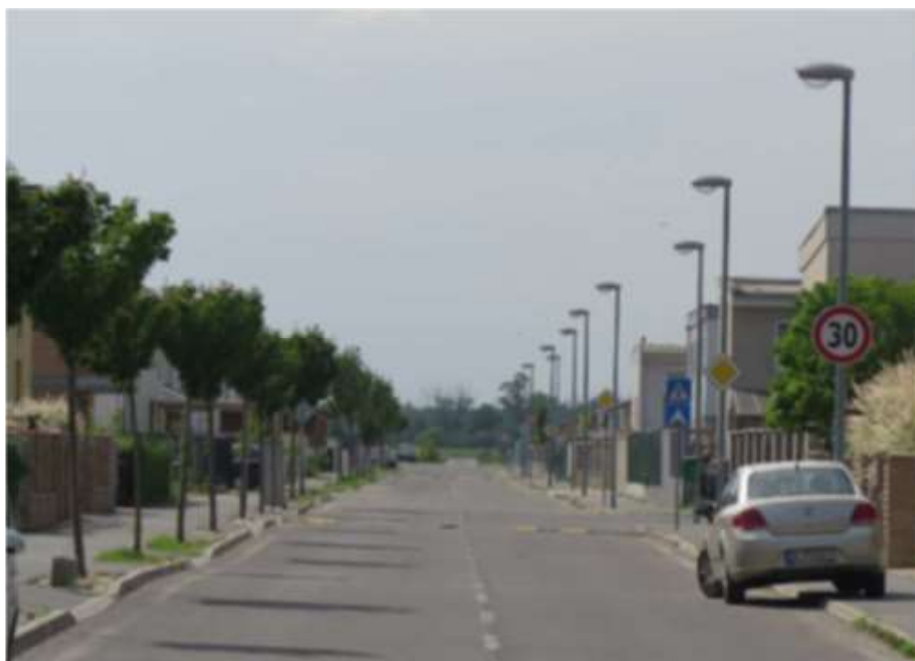
Obrázok č. 80 - Jednostranná sústava so svietidlami SQ 50 v obytnej štvrti (IBV)
