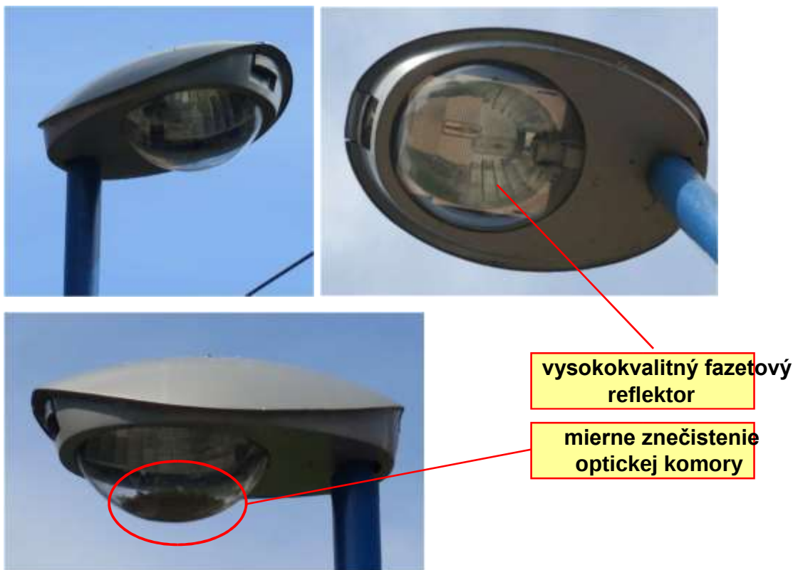
Obrázok č. 60 - Svietidlo typu SQ 50 na Záhumenskej ul.
