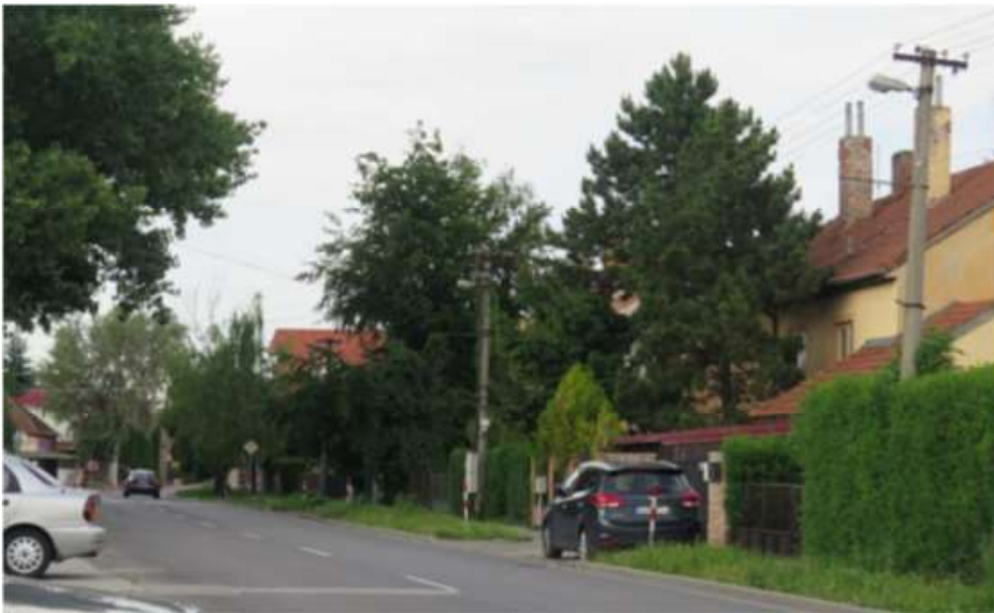
Obrázok č. 93 - Distribučné stožiare sú ďaleko od okraja osvetľovanej komunikácie na Vetvárskej ulici Špecifickým príkladom nevhodne umiestnených stožiarov je osvetľovacia sústava na Námestí 4. apríla, a to kvôli nevyhovujúcemu optickému vedeniu vodiča. Stožiare sú inštalované na vnútornej strane
