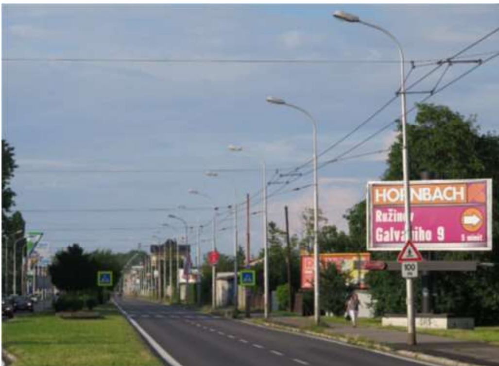
Obrázok č. 79 - Jednstranná osvetľovacia sústava s vonkajšími radmi svietidiel na Rožňavskej ul.
