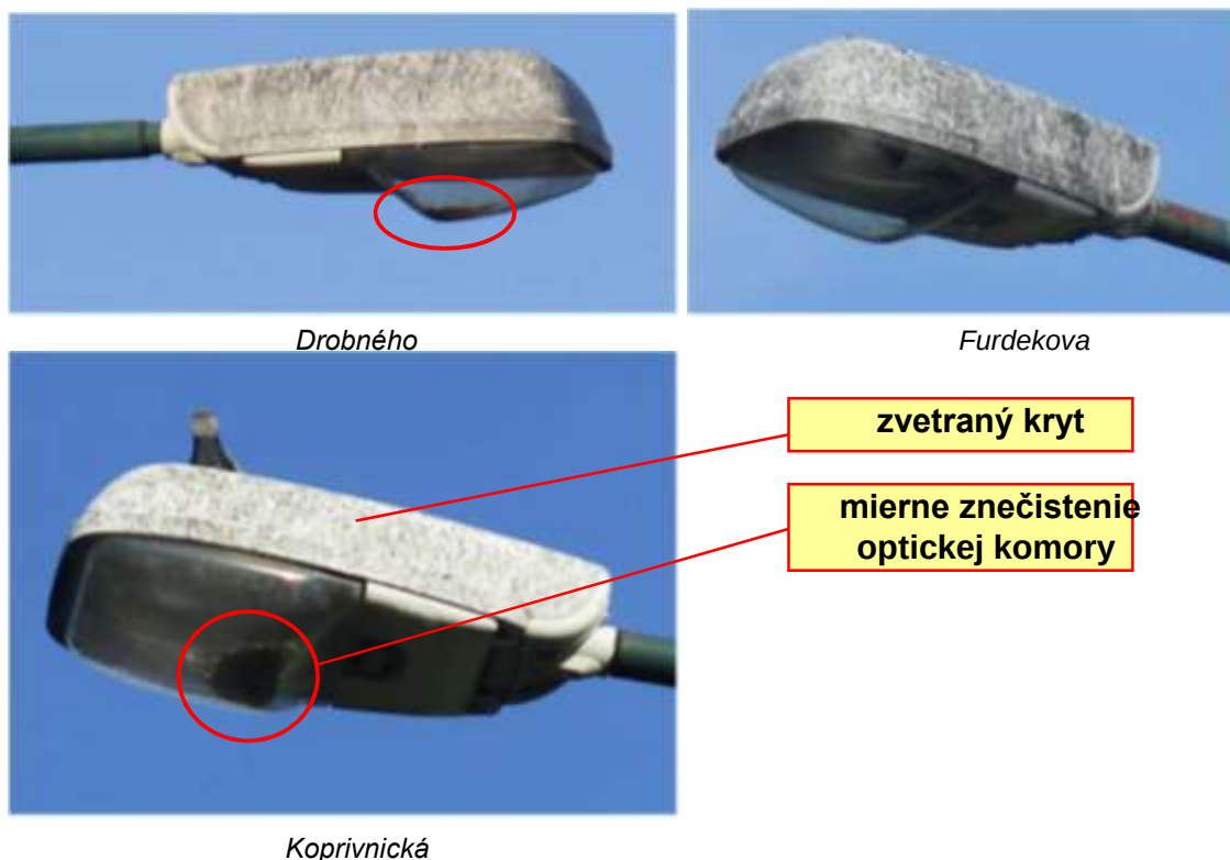
Obrázok č. 54 - Mierne znečistené svietidlá so zvetranými krytmi (typový rad SR)
