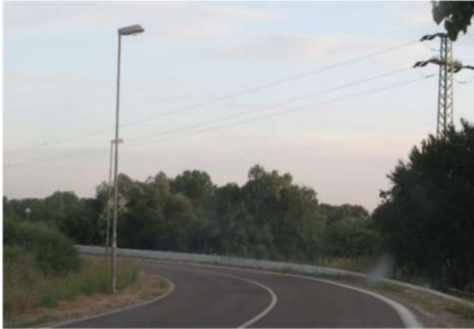
Obrázok č. 94 - Zlé optické vedenie na Námestí 4. apríla
