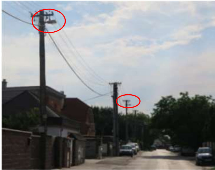
Obrázok č. 92 - Svetidlá inštalované len na každom druhom stožiaru distribučnej siete nn na Priehradnej ulici
