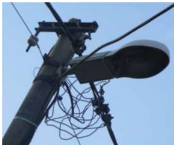
Obrázok č. 75 - Rozvody závesnými káblami na ul. Borinská IV
