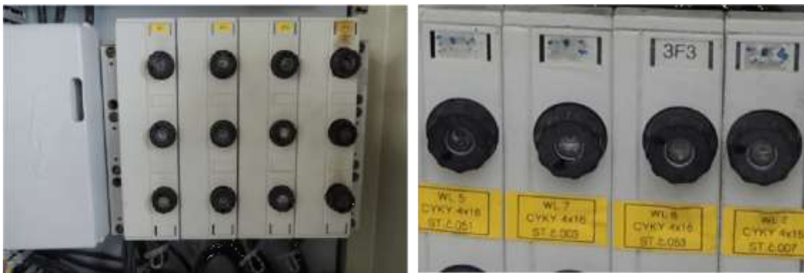
Obrázok č. 38 - Vývodové poistkové polia a ich detail s označením
