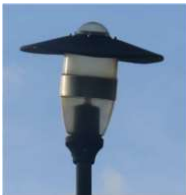
Obrázok č. 59 - Poškodené parkové svietidlo typu Auris na ul. Borinská IV
