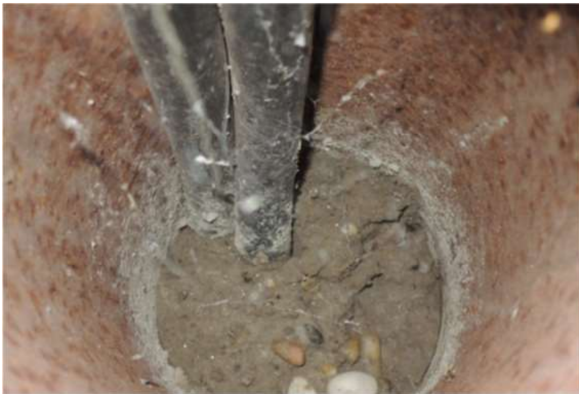
Obrázok č. 65 - Korózia vnútornej steny stožiarov na Tbiliskej ul.
