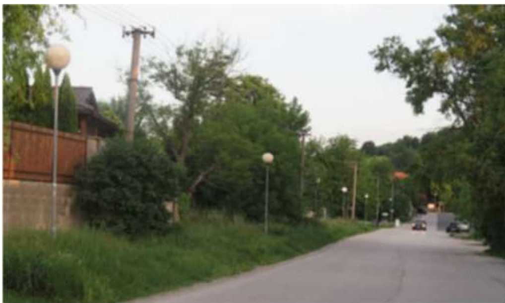
. 84 - Parkové svietidlá typu Vollkugel použité na osvetlenie Muránskej ul. Osvetľovacia sústava na trakčných stožiaroch
