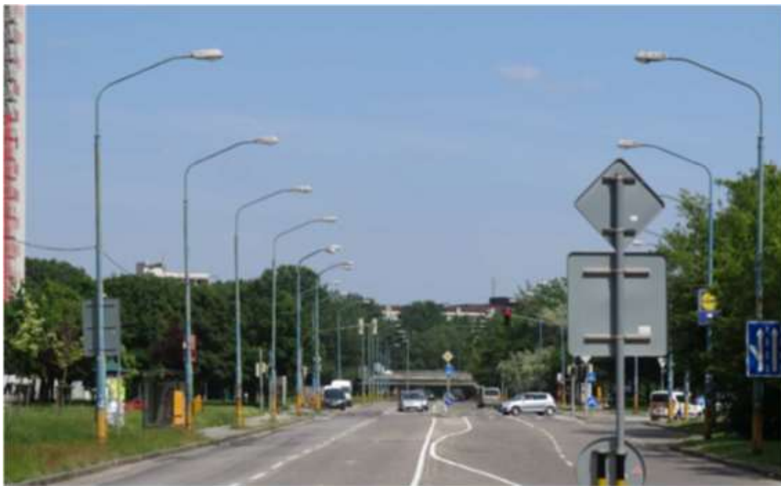
Obrázok č. 76 - Pravidelná párová osvetľovacia sústava na Bosákovej ul.
