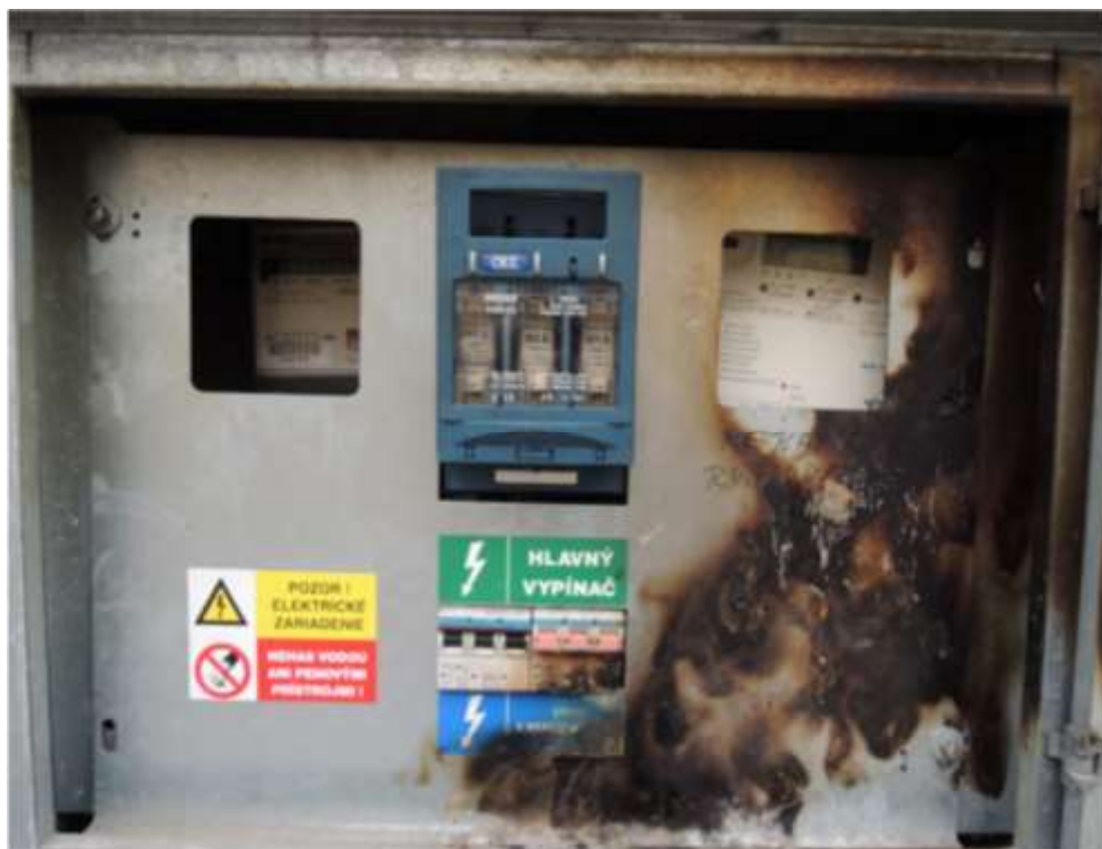
Obrázok č. 96 - Stopy požiaru v elektrovýzbroji RVO 241
