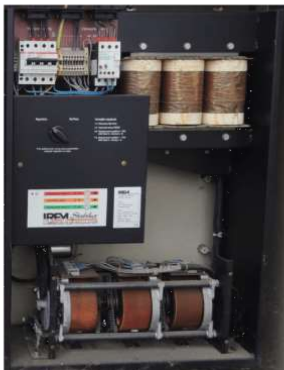
Obrázok č. 42 - Regulátor osvetlenia IREM Stabilux
