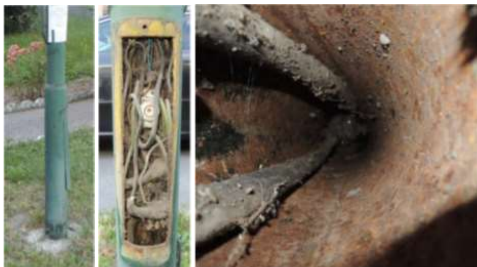
Obrázok č. 62 - Stav vonkajšej a vnútornej časti stožiaru č. 030/027 na Karpatskom námestí.
