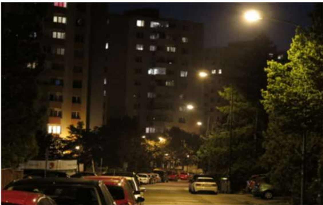
Obrázok č. 114 - Osvetlenie vnútroblokov na Koprivnickej ulici z vysokých stožiarov
