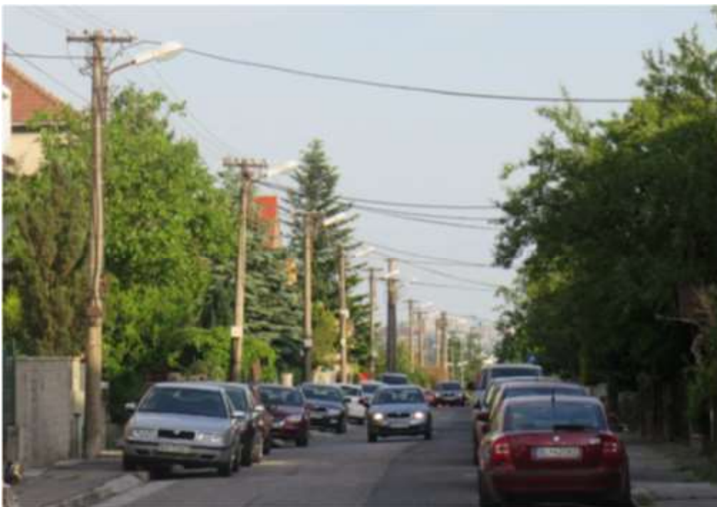
Obrázok č. 88 - Osvetľovacia sústava na distribučných stožiaroch na ul. Pod Zečákom: svietidlá inštalované pod holými vedeniami
