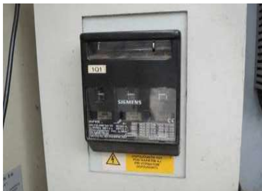
Obrázok č. 43 - Poistkový odpínač
