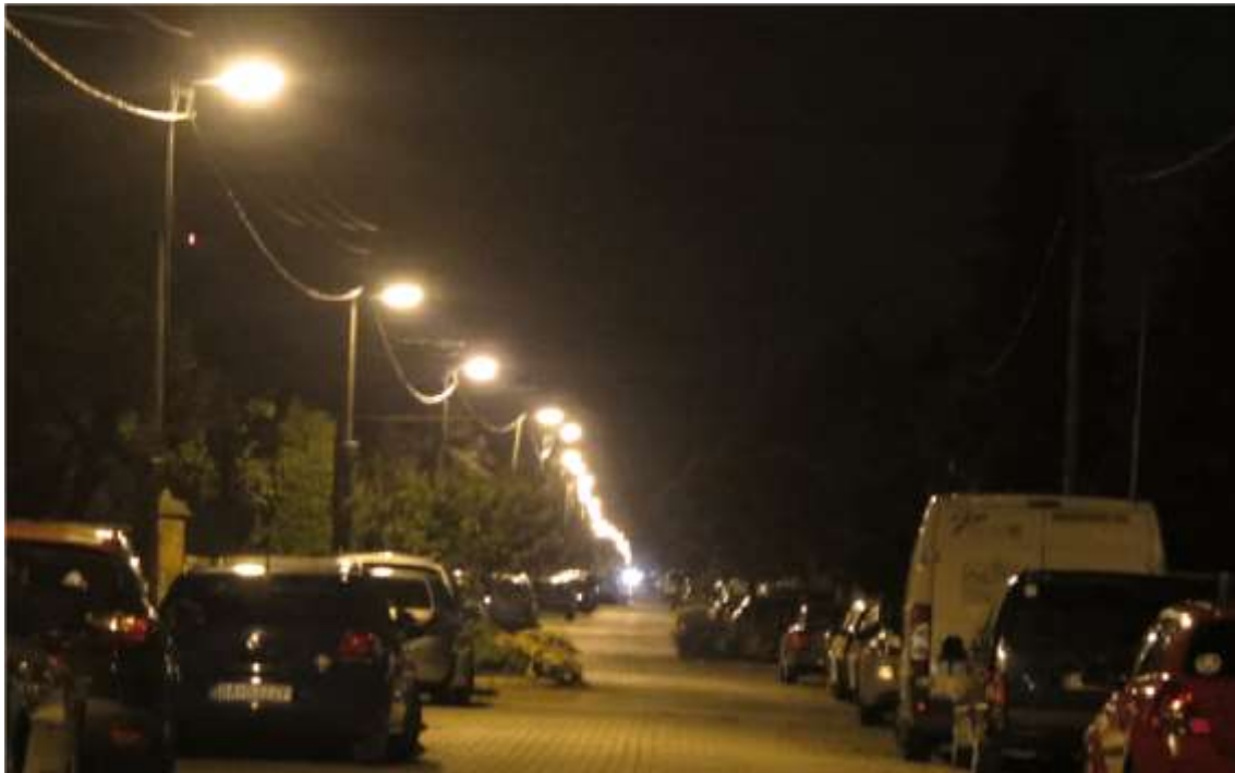
Obrázok č. 121 - Dostatočne intenzívne a rovnomerné osvetlenie svietidlami na distribučných stožiaroch na Kováčovej ulici
