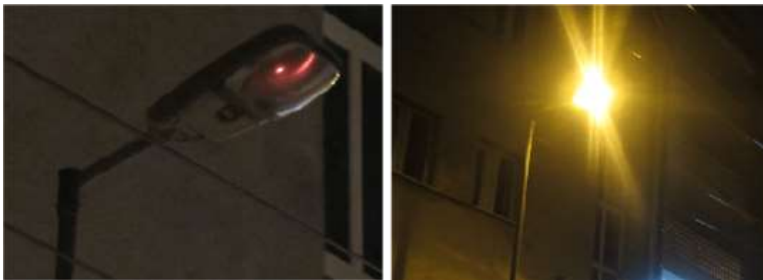
Obrázok č. 100 - Zhasínajúca sodíková výbojka na Palisádach
