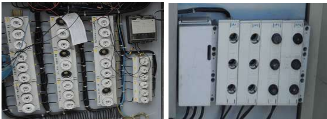
Obrázok č. 44 - Poistkový blok istenia vetiev
