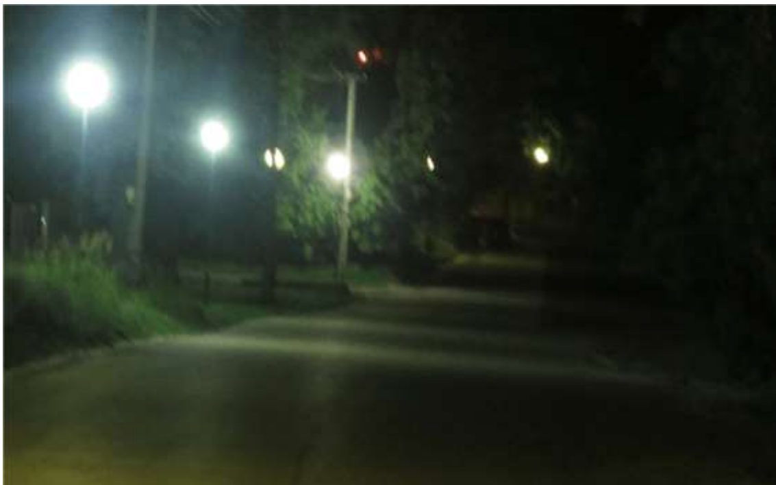
Obrázok č. 119 - Typické „pruhovanie“ so zhoršenou pozdĺžnou rovnomernosťou osvetlenia na Muránskej ulici
