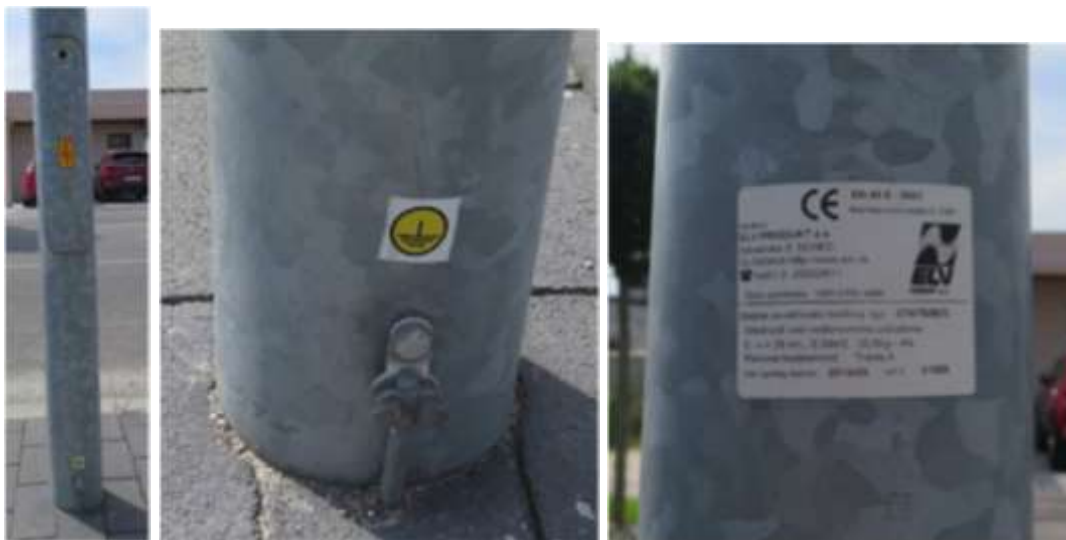
Obrázok č. 72 - Detail uzemnenia a detail štítka pozinkovaného stožiaru z roku 2010
