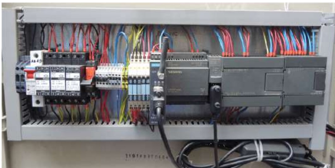
Obrázok č. 41 - Riadiaci systém SIMATIC
