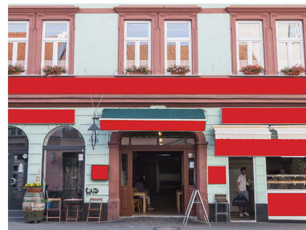
❌ Reklamné prvky prekývajú historické prvky fasády, vstupu do dvora a aj rímsu.
